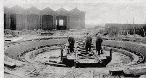
Foto uit 1910 van de bouw van de draaischiff. www.oudezijmemories.nl
